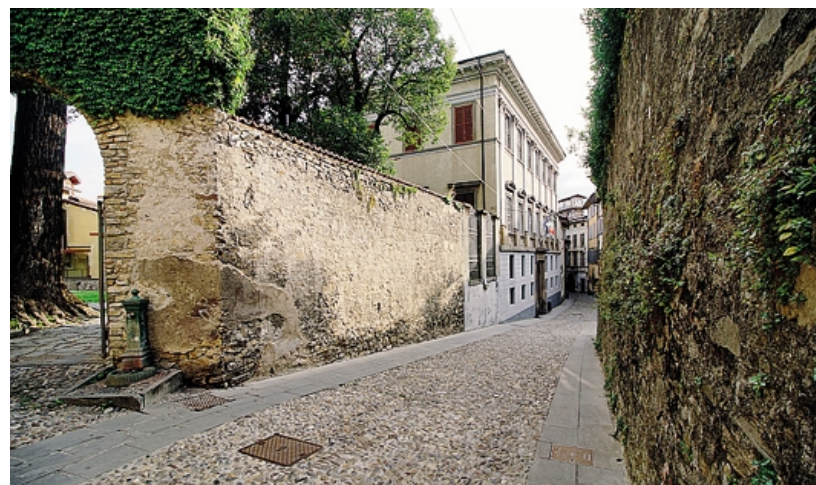
Anche i muri in pietra che delimitano il giardino saranno restaurati
